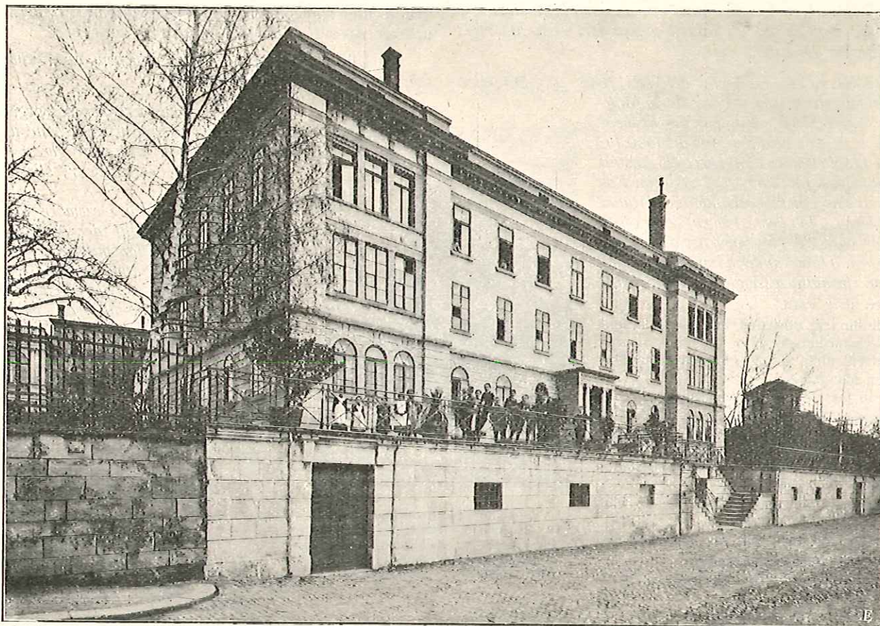
Die Blinden- und Taubstummenanstalt Zürich an der Künstlergasse nach ihrer Vergrößerung (Aufbau). Jetzt steht dort die neue Hochschule. — Siehe Seite 272.
